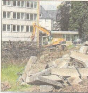
Die Arbeiten haben begonnen.
